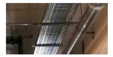
"Dank gebrauchsfertiger Sets mit entsprechender deckenseitiger Endung sowohl für Beton als auch für das Trapezblechdach, konnten wir die Kabeltrassen problemlos und schnell abhängen."
