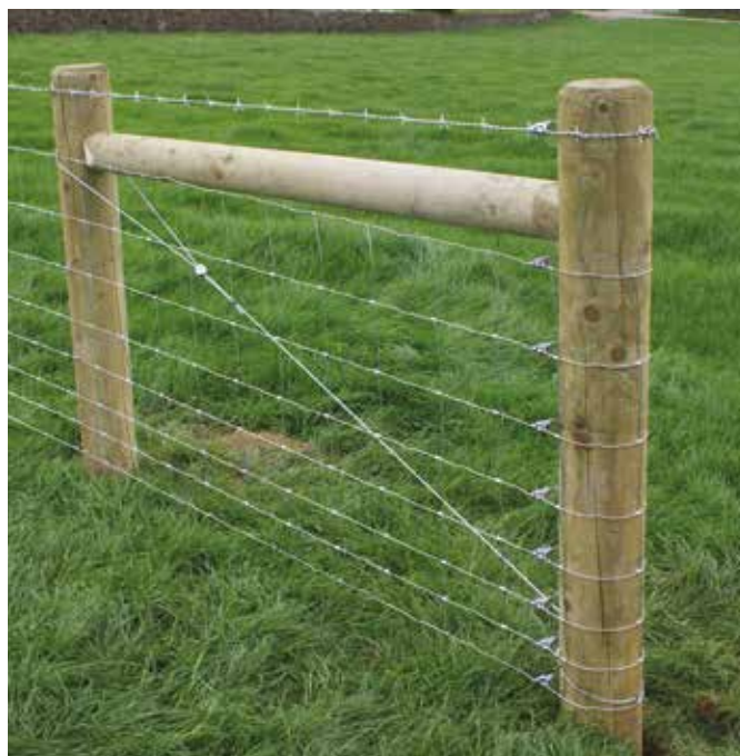
FPAK installé sur un renfort d'extrémité
