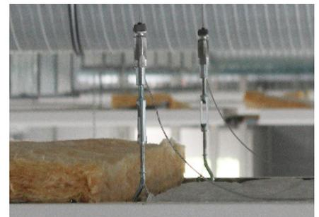
„Wir konnten mit dem Gripple System **bis zu 20 Minuten pro Abhängung** sparen. Bei 1300 Befestigungspunkten ist das eine erhebliche Zeitersparnis.“
