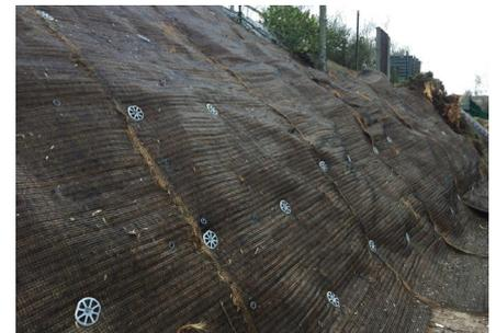
No fue posible instalar un muro de contención con excavadora debido a la falta de espacio y la dificultad de acceso. Terra-Lock se convirtió en la solución ideal gracias a su facilidad de instalación con herramienta ligera.
