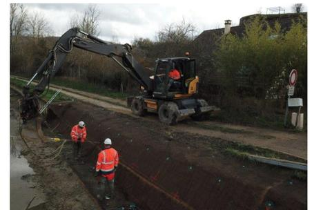
Nell'ambito di questo progetto il sistema Terra-Lock si è dimostrato vincente per due fattori fondamentali: il geotessile resistente ed ecologico ha dato prova di un'importante azione drenante sul terreno circostante e, inoltre, ha consentito la ricrescita della vegetazione. In questo modo è stato possibile ripristinare l'aspetto naturale della sponda, essenziale per questa via navigabile turistica.
