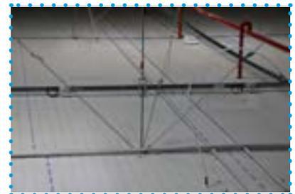
Les kits d'haubanage parasismiques prêts à l'emploi sont composés d'une longueur de câble avec embout serti et étiquette de couleur, un galet autobloquant et un étrier Standard ou Rétrofit.
