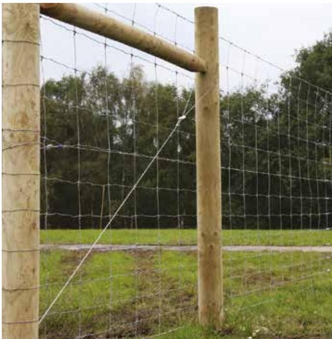
FPAK - Abspannung Endpfosten
