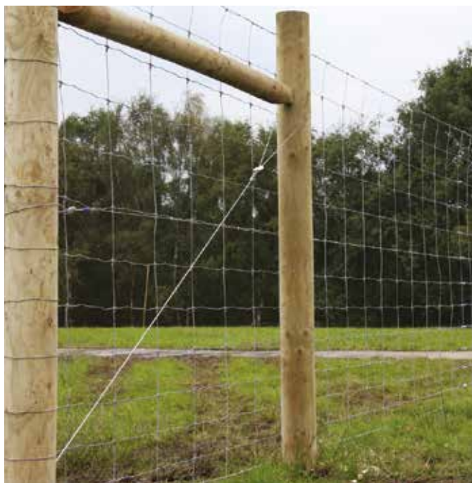
FPAK - Stabilisation de piquets de clôture
