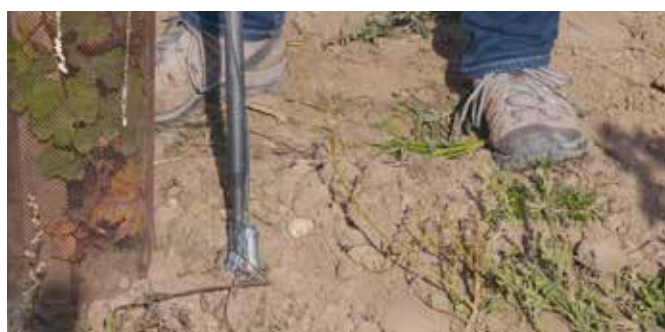
Haut : Ancre 3 et Tige d'Enfoncement Bas : Ancre 3 en train d'être enfoncée
