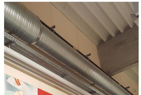
Mit Gripple schaffe ich **80 m bis 100 m Wickelfalzrohr** am Tag zu montieren, je nach Leitungsführung! Bei gerader Führung 100 m und bei einigen Bogenstücken bis zu 80 m!"
